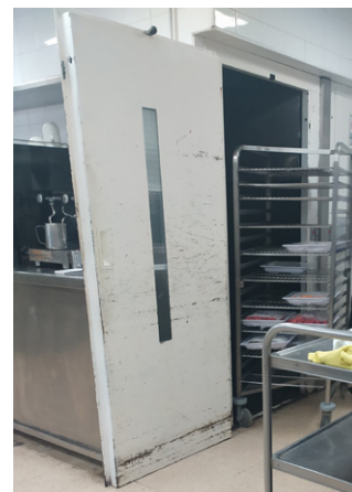
Ascensor para transportar comida entre varias plantas.
